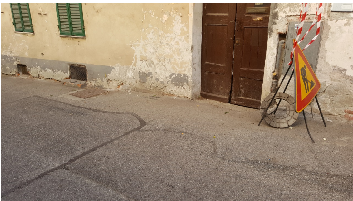
Via Cavour, chiusino fuori quota, aperture da proteggere
