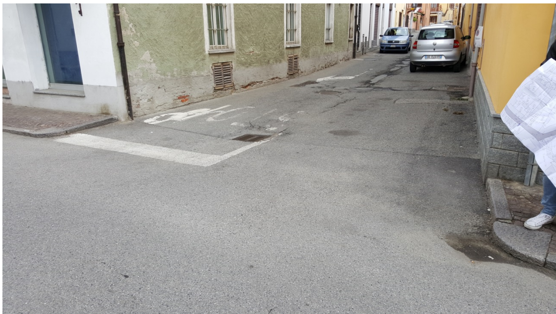
Inizio Via Garibaldi, griglia da sostituire, zoccolatura in pietra
